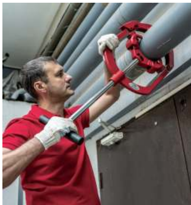
Режущие ролики
